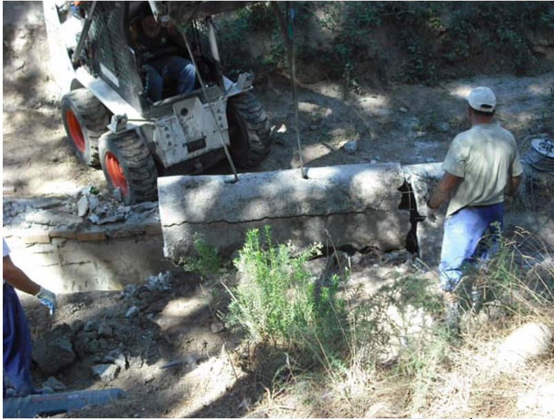
LAM. 1 TRABAJOS DE DESMONTE DE LA BÓBEDA
