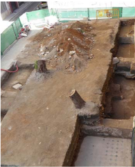
Vista aérea del CE-01, CE-07, CE-08 y parte del CE-04
