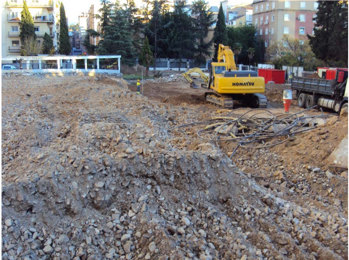
Foto 1. Retirada de las capas superficiales.
