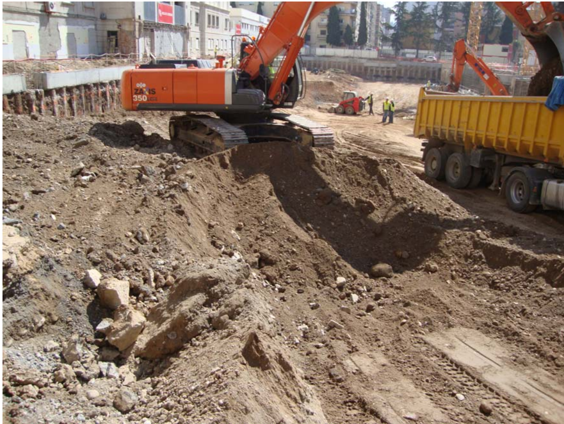
Foto 7. Rebaje de tierra durante la 2ª fase en el sector 4
