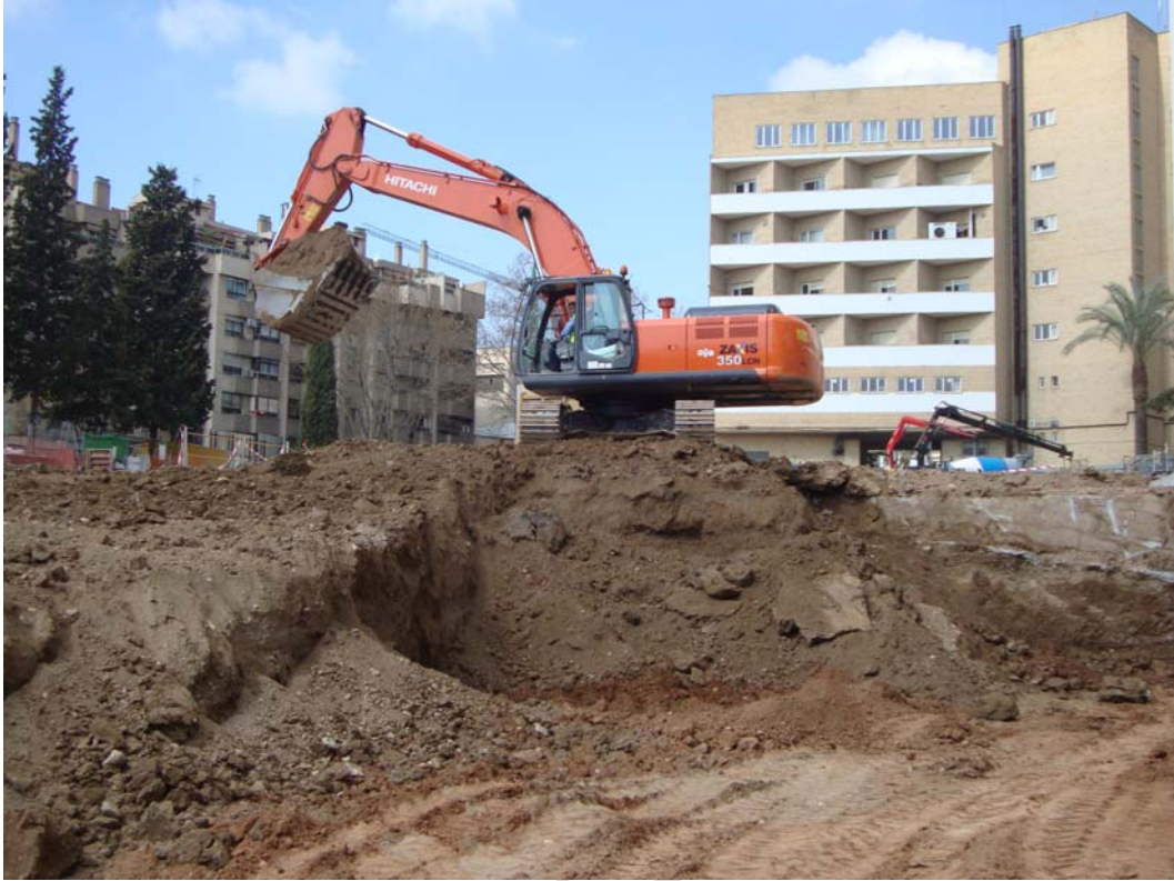
Foto 6. Rebaje de tierra durante la 2ª fase en el sector 2
