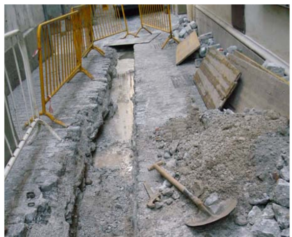
Lam. 6: Vista del segundo tramo de zanja Convalecencia abierto.
