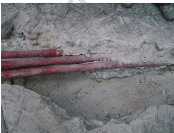
Lam. 5: Vista de la zanja Convalecencia con los tubos de abastecimiento ya existentes.
