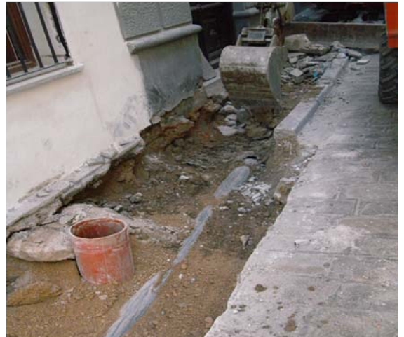
Lam 8- zanja en tramo Jesús y María
