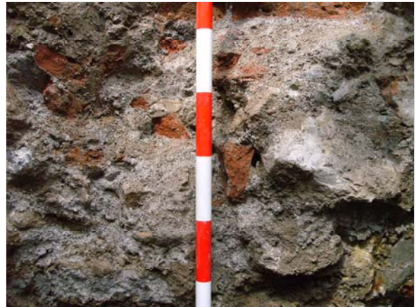
Lam. 2: Detalle de la E-003 con ladrillos, cantos y mortero de cal
