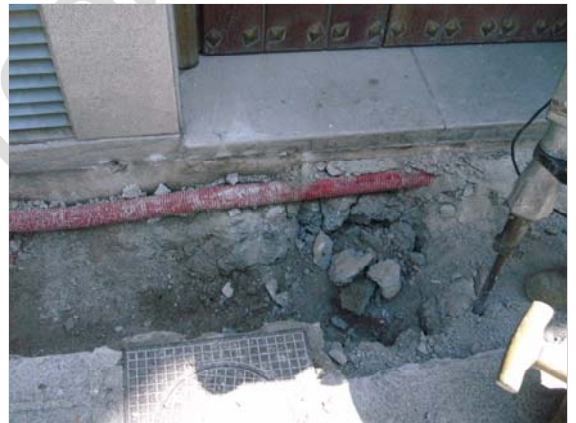
Lam. 10 (arriba): Zanja en tramo de Zacatín
