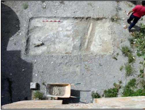
Fotos 1 y 2: Capa de cal niveladora, pavimento empedrado original del patio y red hidráulica del siglo XX.
