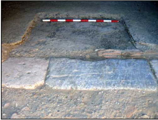
Fotos 6 y 7: Detalle del suelo de cemento pulido que cubría el empedrado original de las Caballerizas, UF-12.
