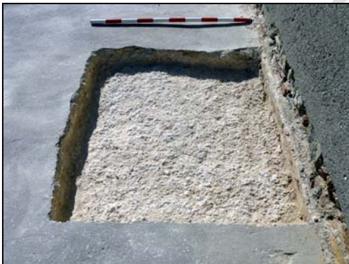
Foto 19: Detalle de uno de los rellenos constructivos del encofrado de las bóvedas.
