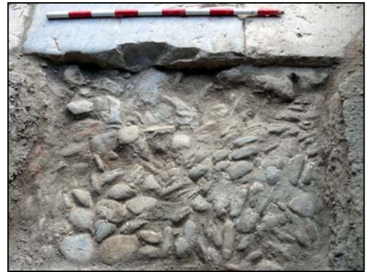
Fotos 6 y 7: Detalle del suelo de cemento pulido que cubría el empedrado original de las Caballerizas, UF-12.
