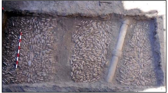
Fotos 1 y 2: Capa de cal niveladora, pavimento empedrado original del patio y red hidráulica del siglo XX.
