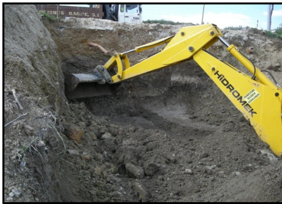
Fig. 2. Proceso de excavación.
