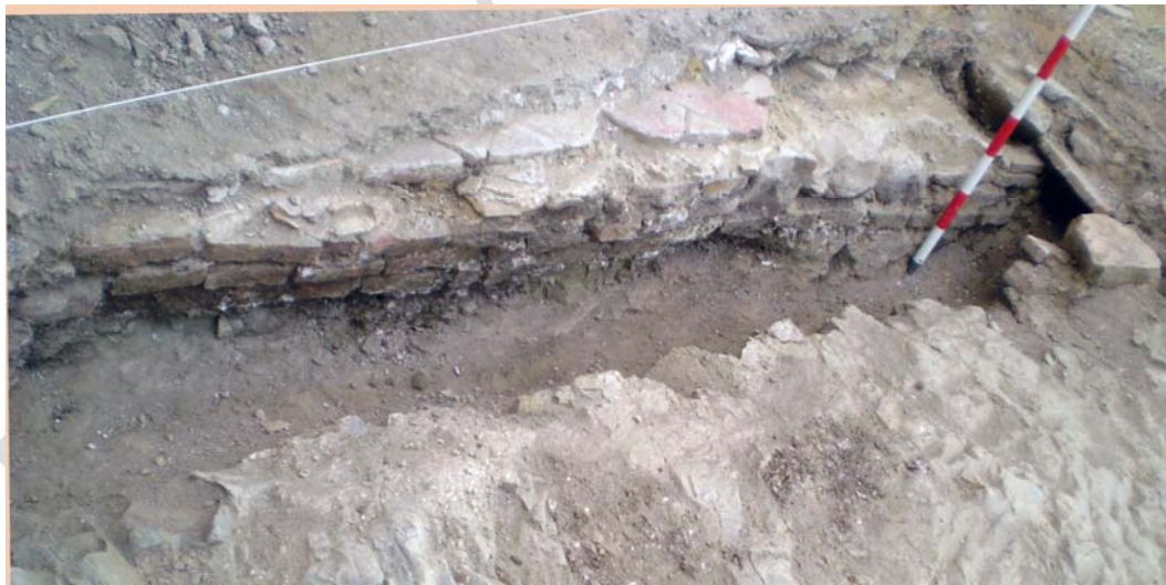
Lám. 6 Pavimento de baldosas y debajo atarjea (C.E.1).
