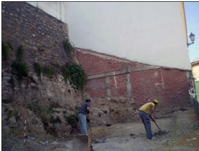
Lám. 11 Al fondo del solar se puede observar la medianería de las cocheras con el edificio de la residencia.
