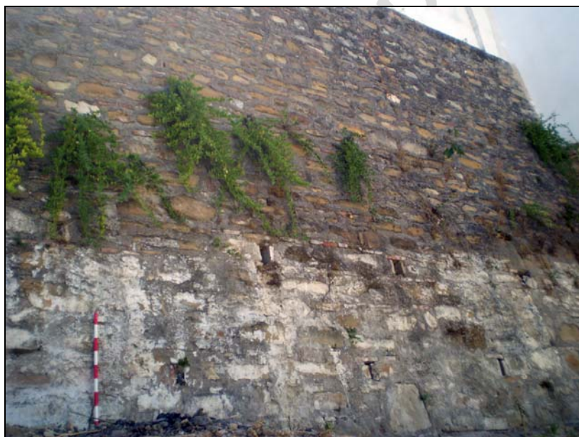
Lám.9 Parte del muro que separa este solar de la Plaza de Santa María, situada a sus espaldas.
