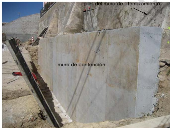
Lam. III: Muro de contención realizado con hormigón.(1º batache)
