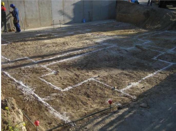
Lam V: Replanteo de la excavación para los pilares.
