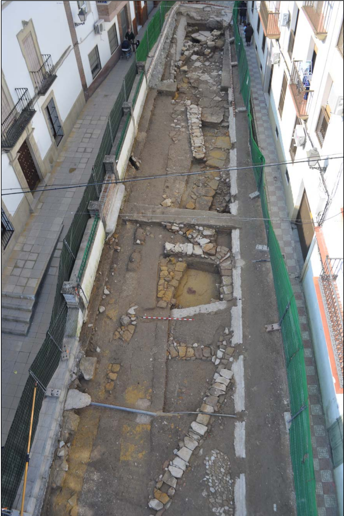
Lám. 11. Vista general del área de la intervención.
