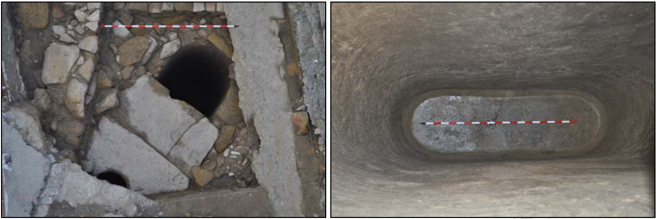
Lám. 04 y 05. Vista en planta del exterior y detalle del interior de la cisterna E-2.
