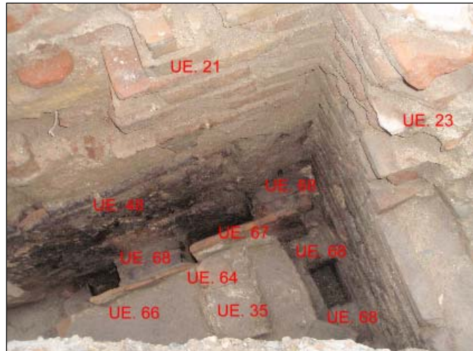
Lám. 7 - Interior del Ámbito B. Vista de la suspensura , con restos de revestimiento en opus signinum , y concamerationes
