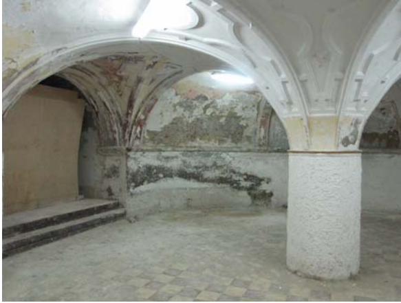
Lám. IV Capilla subterránea
