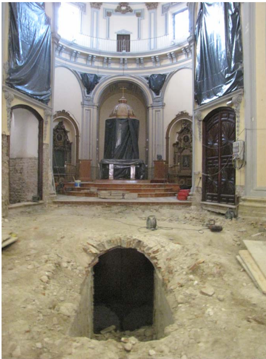
Lá. III. Acceso a capilla subterránea.
