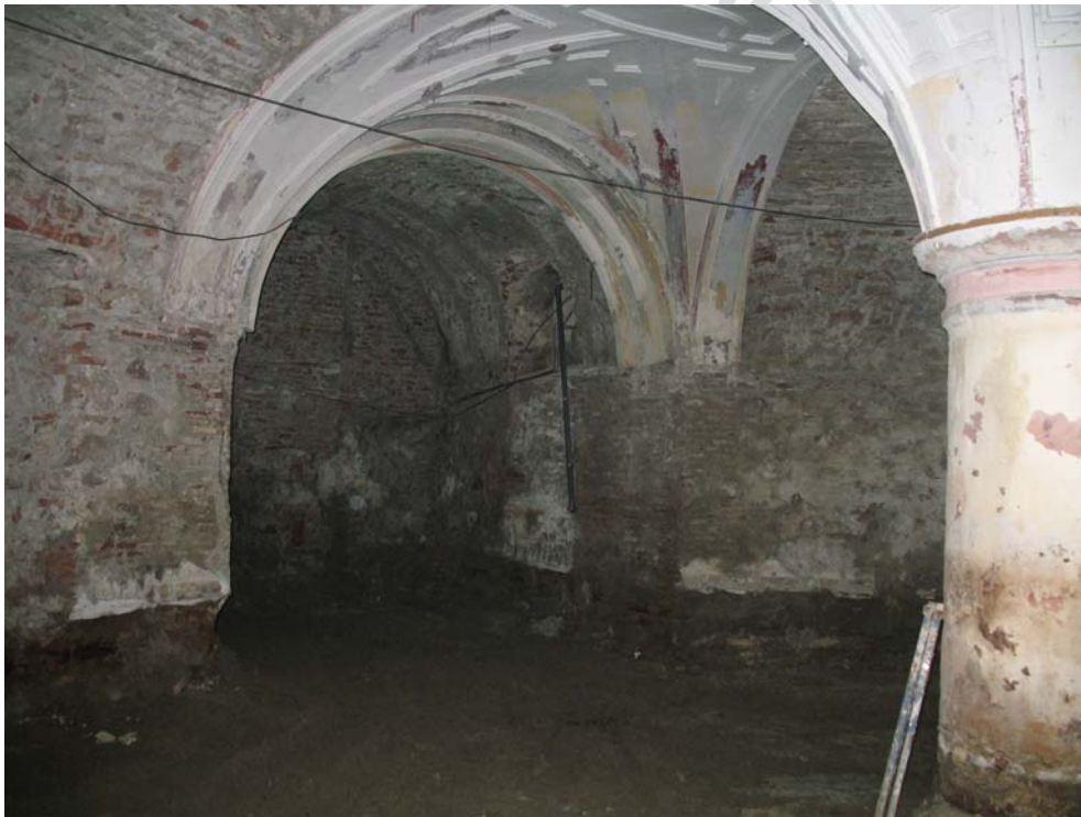
Lám VI. Vista de la capilla al alcanzar la cota de afección.
