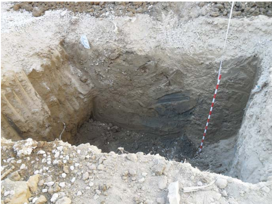
Fig.9. Excavación de la Zanja 1.
