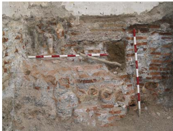
Lám.XI U.E.E. 84 – Batería de canalizaciones
