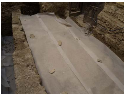
Láms. XII,XIII Cubrición con geotextil y gravas
