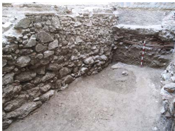
Lám IX- U.E.E. 74: Cimentación de la crujía (UU.EE. 4, 5)
