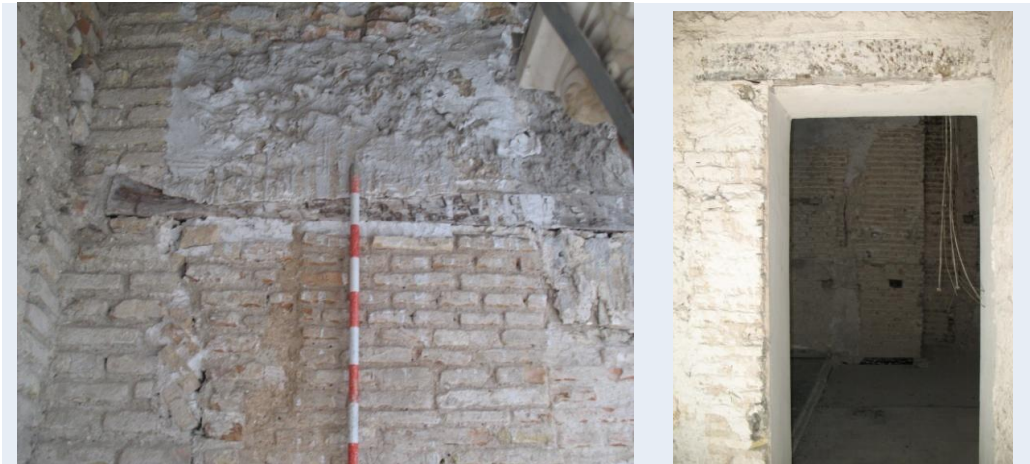
Vanos con costero de madera tipo 1a documentados en la estancia 5 (alzado I-I', H-H')
