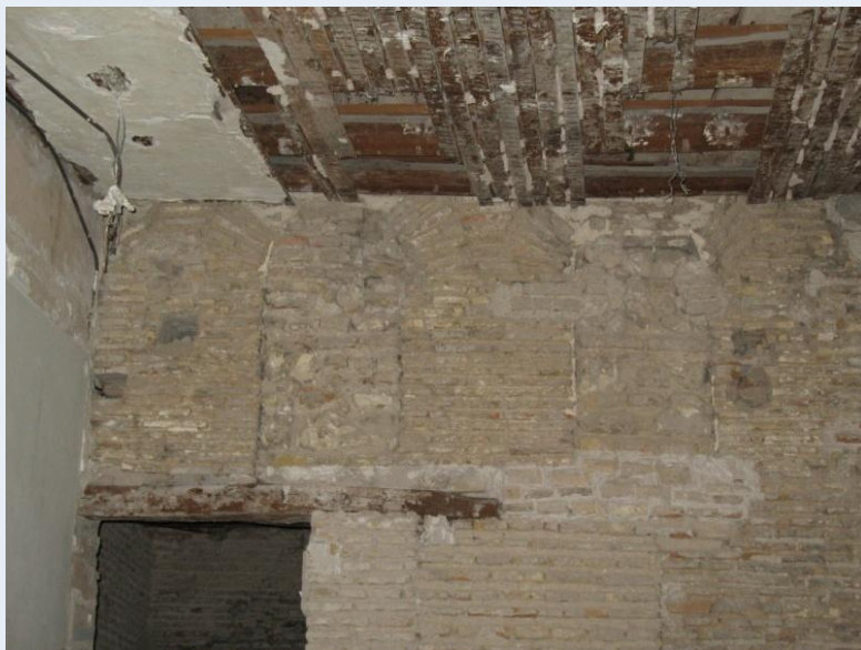
Ventanucos de medio punto rebajados abiertos durante el proceso de ampliación de la torre islámica.
