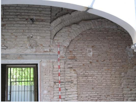
Vista del arco de medio punto tipo 11a desde la estancia 5 y 1 respectivamente
