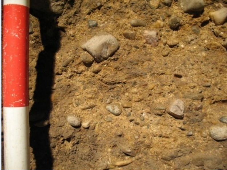
posición del tapial 1.1. Se observa la ausencia total de machaqueo y la selección de la grava
