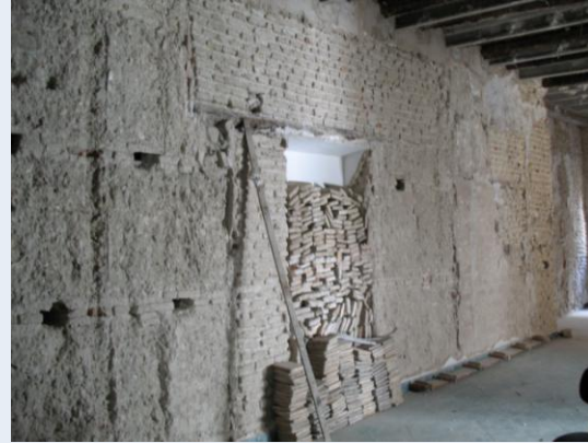
Estancia 12. Medianera occidental de tapial mixto con apertura de vanos posteriores (s. XVII-XVIII) cuando se agrega la parcela vecina.
