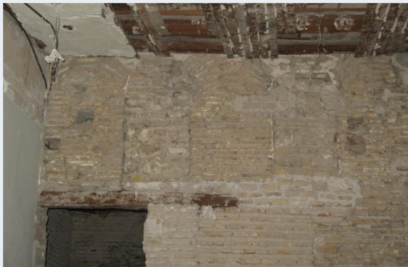
Estancia 12. Vanos en el frente Norte de la cámara.
