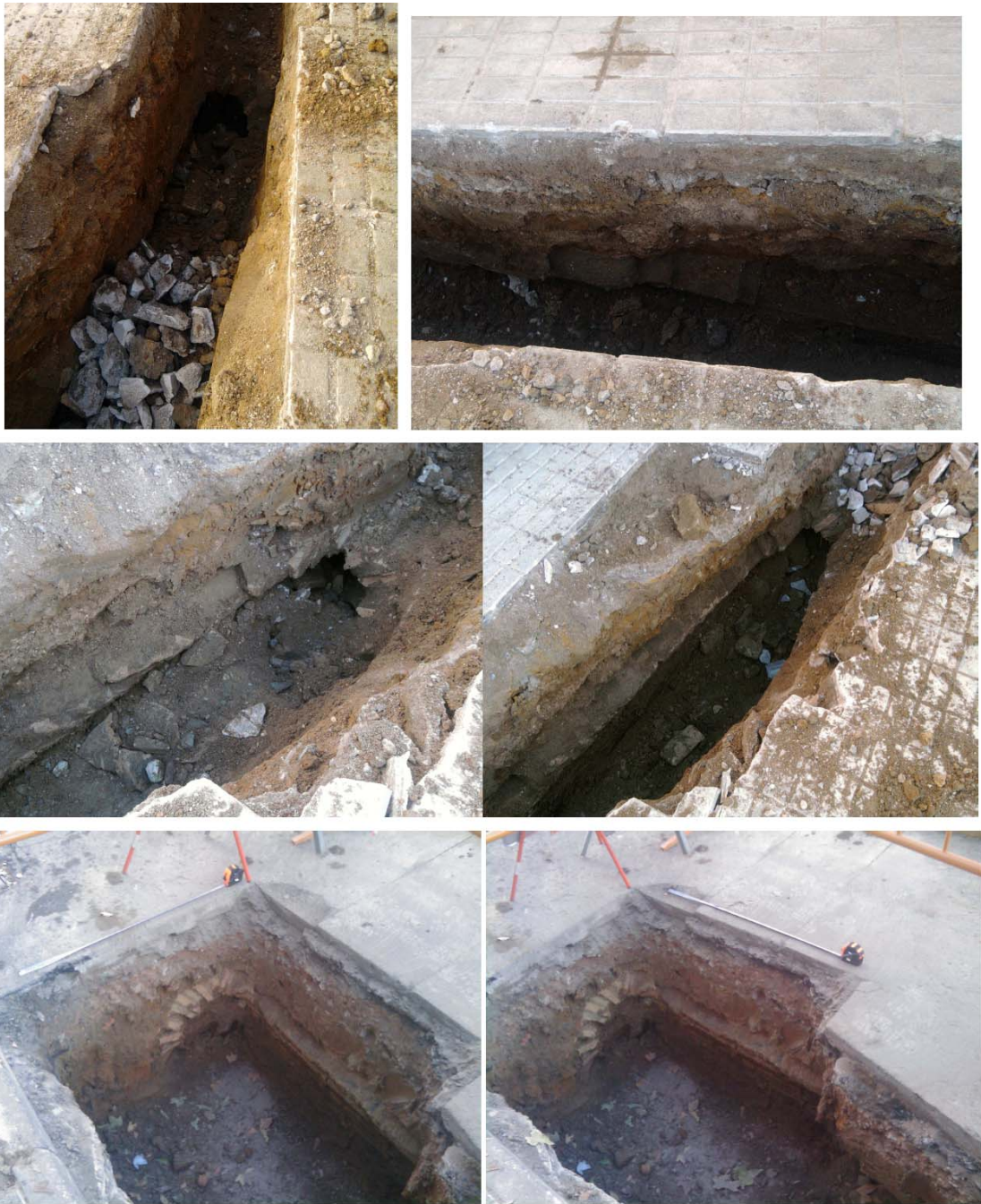
Lam 2. Estructura constructiva con forma de bóveda aparentemente relacionado con el alcantarillado realizado a cargo de D. Clemente de la Cuadra y Gibaxa en la década de los 40 del s.
