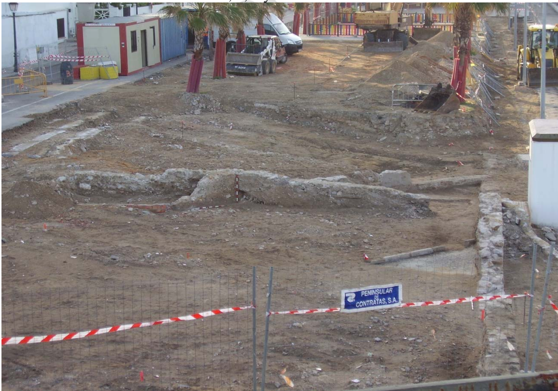
Lámina 6. Cimentación y alzado de la estructura 4, sobre el pavimento 06.
