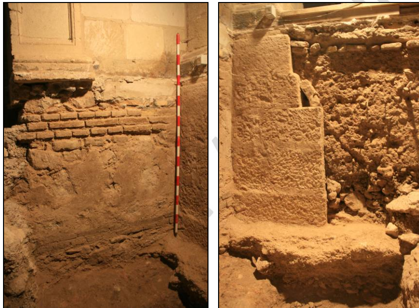
Ilustración 19 Cimentaciones de la entrada a la capilla
