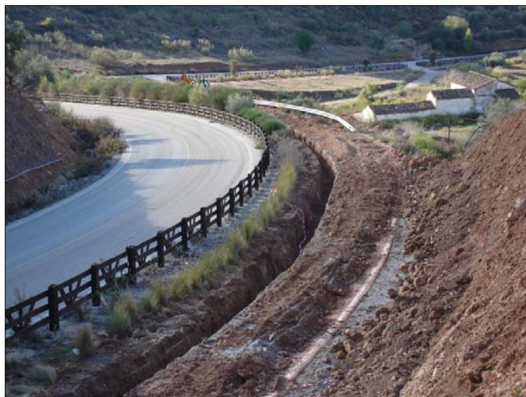
Lámina 13: Vista general del Cortijo Marugán (Elemento etnológico nº 1) durante la ejecución del proyecto de obra
