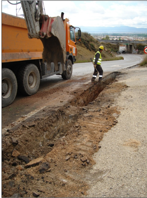
Lámina 2: Trabajos de ejecución de la zanja al inicio del tramo 2.
