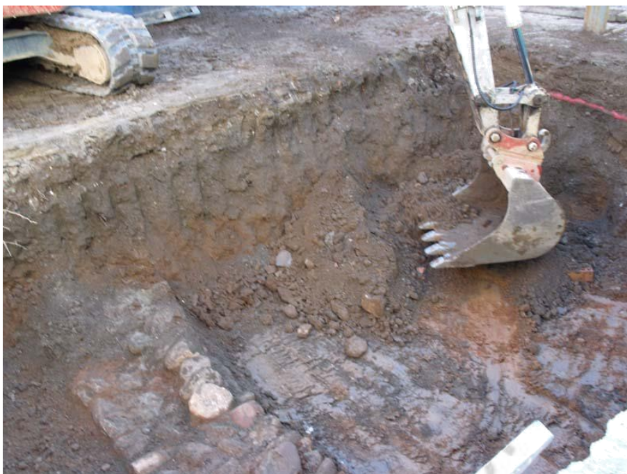
Foto 8: control de movimiento de tierras
