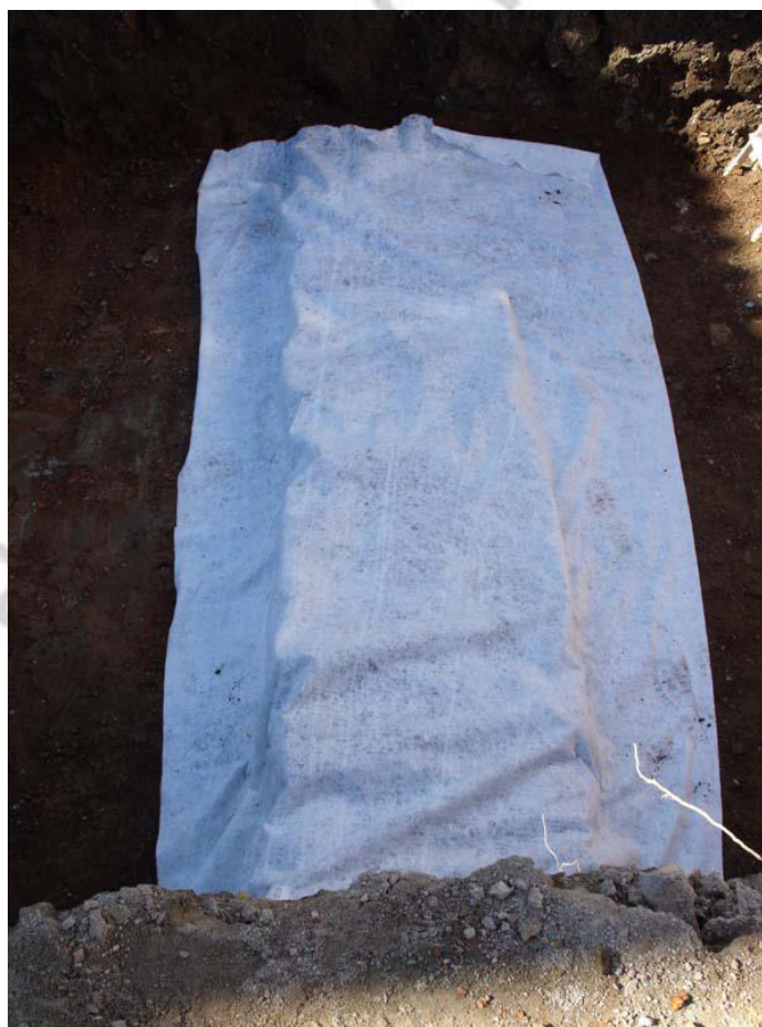
Foto 9: E-001 cubierta con geotextil
