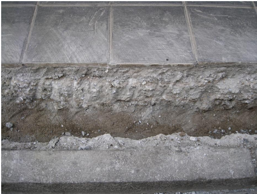
Ilustración 3: Secuencia estratigráfica de la zanja
