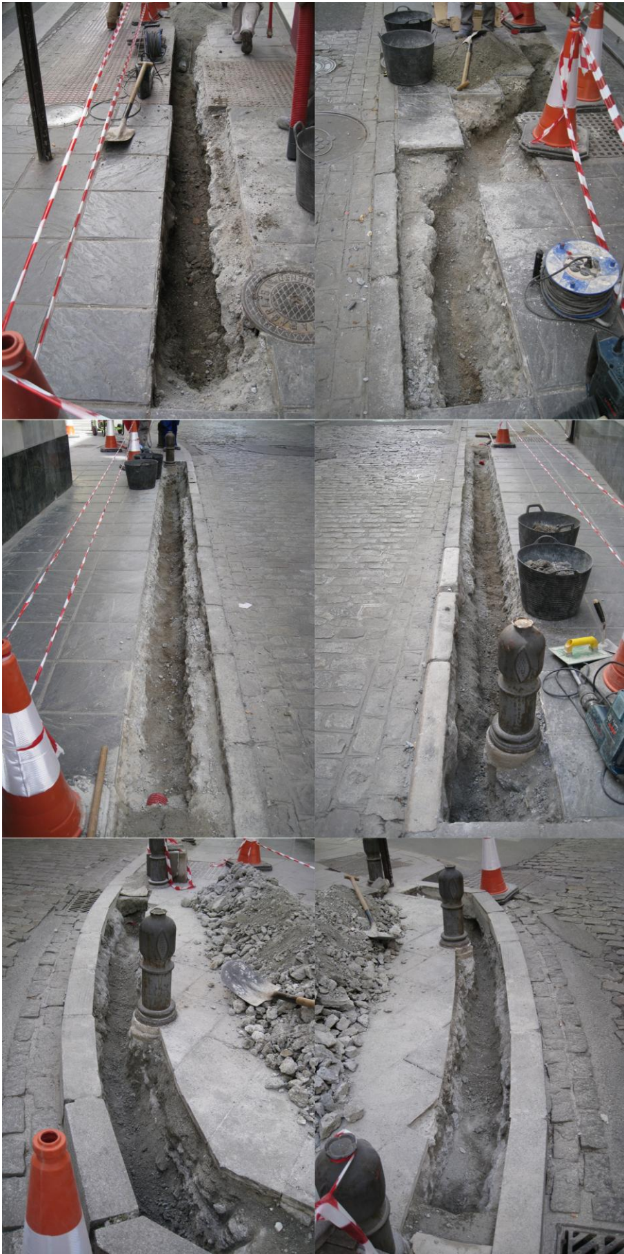
Ilustración 5: Resultado de la apertura de la zanja en sus diferentes tramos.
