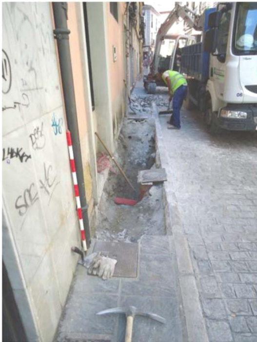
Figura 1. Vista general de la zanja.
