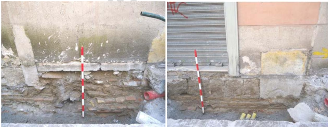
Figuras 2 y 3. Detalle del perfil, edificio antiguo, sillares de la fachada y base de ladrillos.
