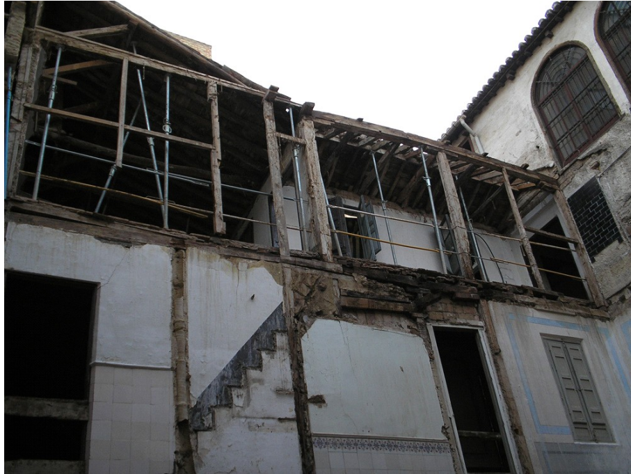
Estado del edificio antes del derribo, primera y segunda planta
