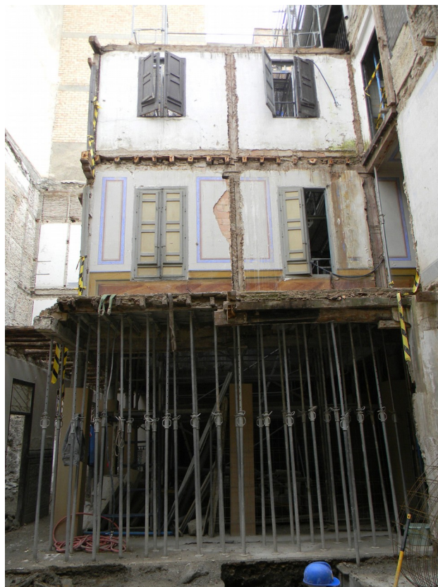
Estado actual del patio, zona ascensor
