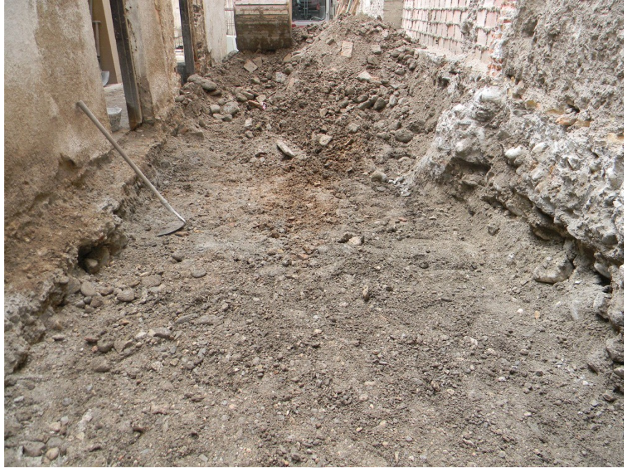
Rebaje de 0,30 m en el área afectada.
