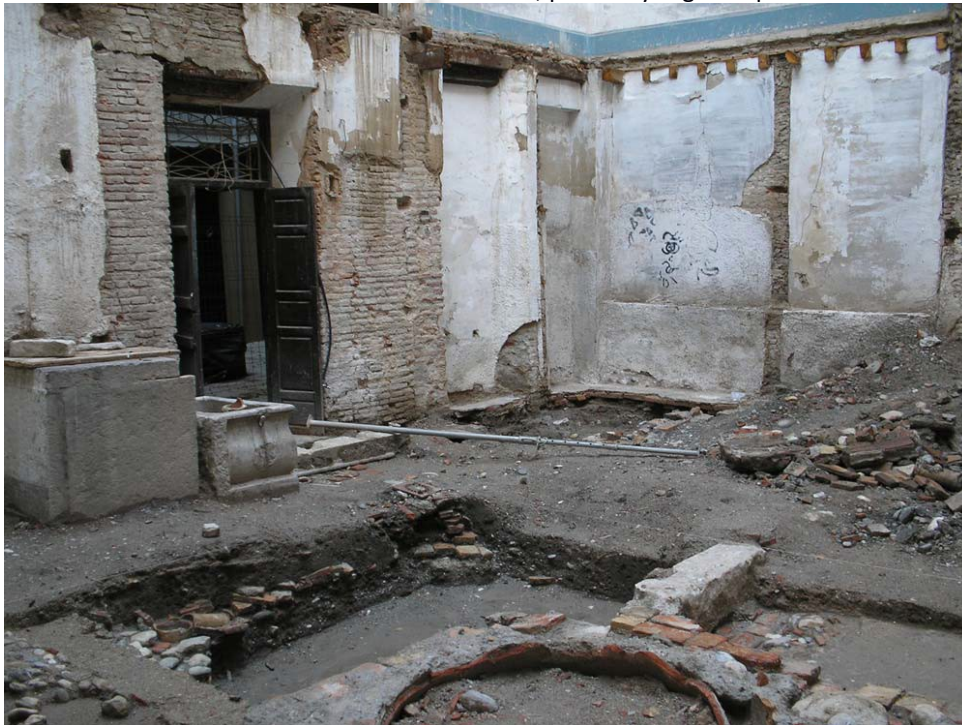
Estado del edificio antes del derribo, zona ascensor
