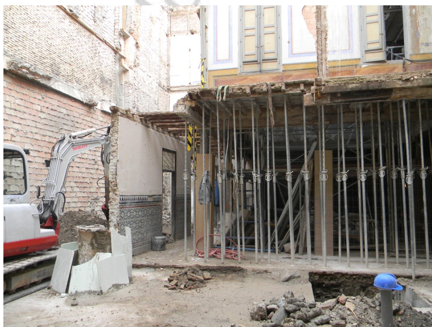
Estado actual, zona ascensor derecha y zona controlada izquierda
