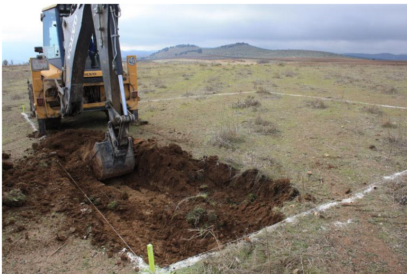
Foto 4: rebaje con máquina retroexcavadora
