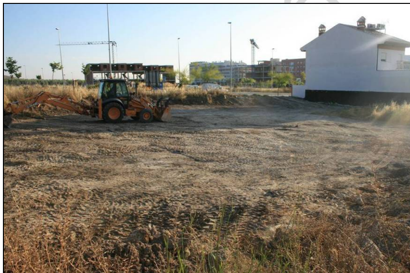
Vista de las labores de desbroce mecánico.
