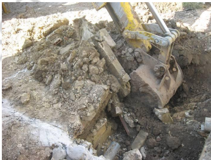
Lám. III - Demolición de la arqueta.
