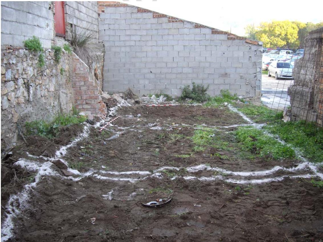
**Fig. 2 Planteamiento de zona de excavación.**
