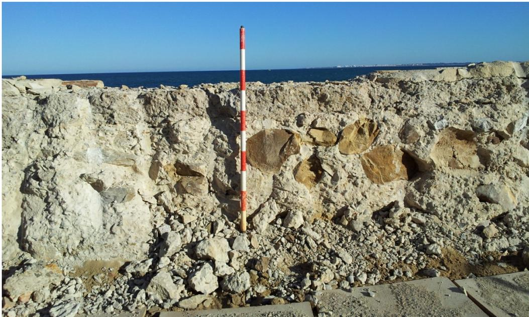
**Foto 2. Interior del muro donde se aprecian los cantos que forman parte del hormigón del que está compuesto.**
