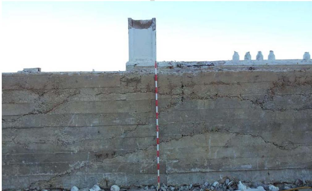
**Foto 1. Muro de hormigón que sirve de soporte y cimentación de la balastrada tras la remodelación de 1975.**
