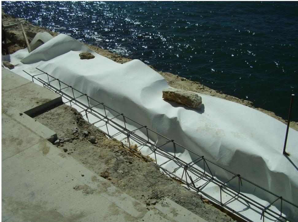
**Foto 3. Vista de la muralla donde la cornisa quedó descubierta cubriéndose con geotextil para evitar cualquier contacto.**
