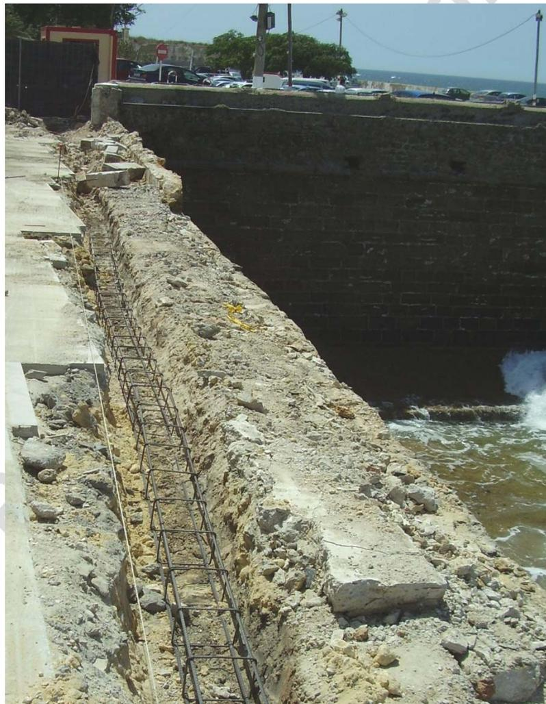
**Foto 4. Vista de la muralla con la esquina del Baluarte del Bonete al fondo, donde se puede ver el zuncho realizado en la parte interior de la muralla, dentro del añadido de subbase, con el armazón metálico para anclar los pilares de la balaustrada. Sobre la muralla se aprecian los restos del muro de hormigón que se encontraba apoyado sobre la cornisa.**
