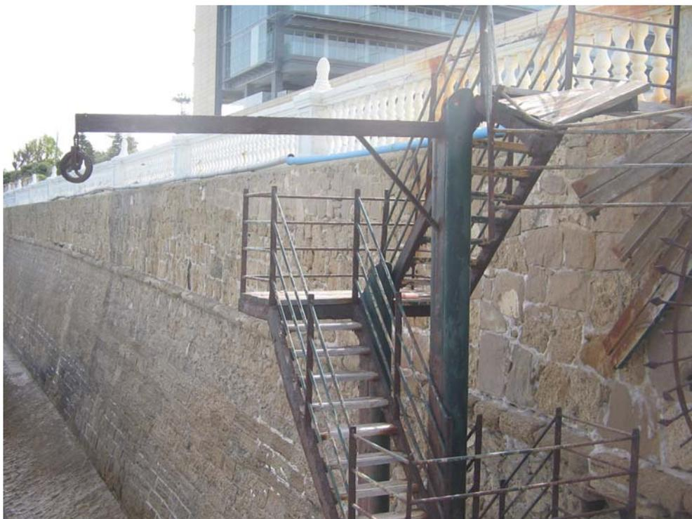
**Foto 6. Vista exterior del tramo intervenido, previa a la actuación. En la parte superior puede observarse el forro de lasjas ostioneras sobre la cornisa. En la parte inferior, la zapata adosada al muro.**
