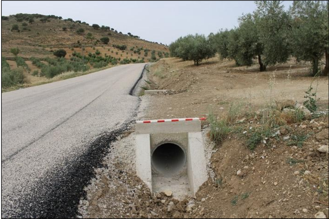
5. Paso de finca al cortijo donde se ubica el yacimiento de Fuente de los Charcones . No se detectaron restos arqueológicos durante el movimiento de tierras
