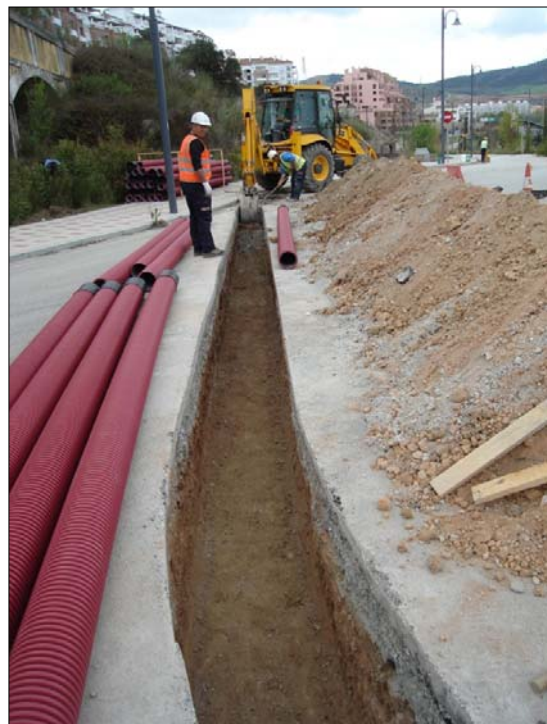
Lámina 6: Ejecución de la zanja en la Urbanización Medina Golf.
