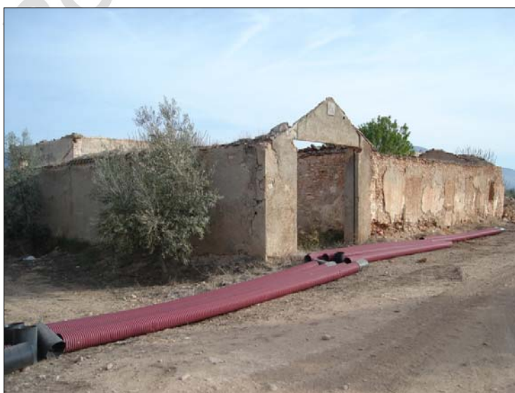
Lámina 12: Vista del Cortijo de Pelostiesos (Elemento etnológico nº5) durante la ejecución del proyecto de obra.
