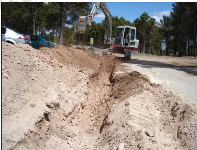
Lámina 4: Excavación de la zanja en el área recreativa y Collado de los pinos. Tramo 3.
