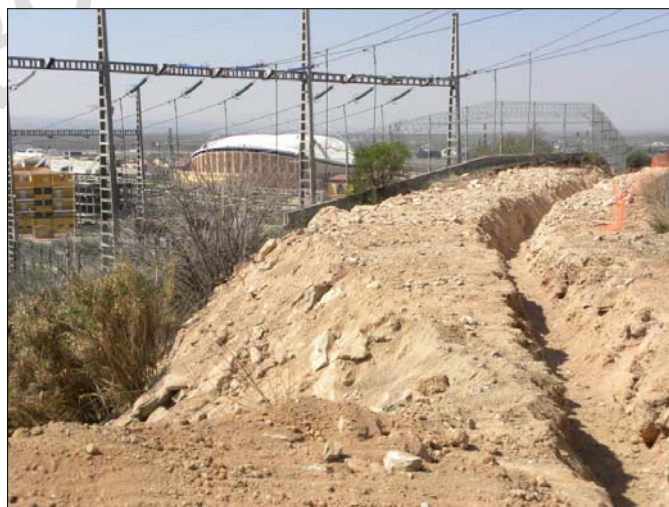
Lámina 1: Inicio de la zanja, subestación de Atarfe.
