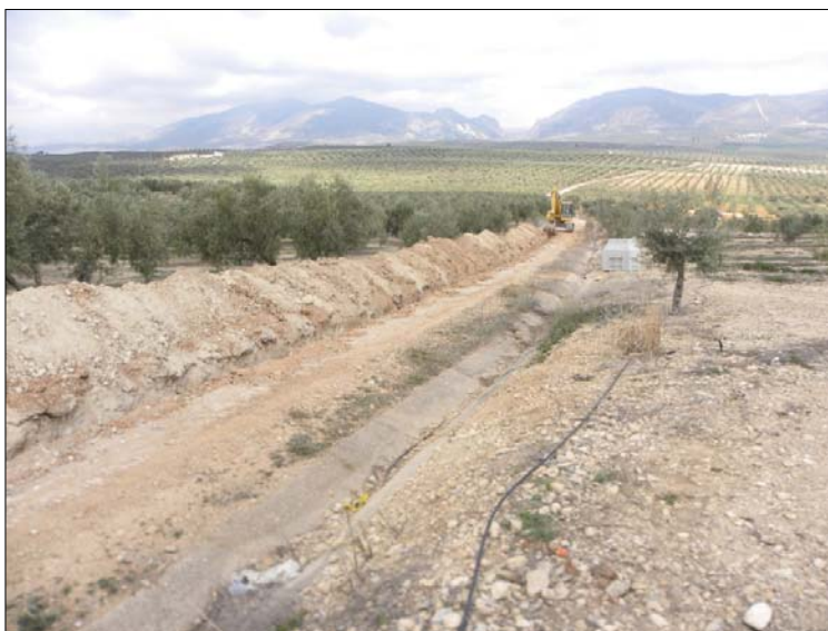
Lámina 11: Vista de la zanja desde el S. Tramo 7.
