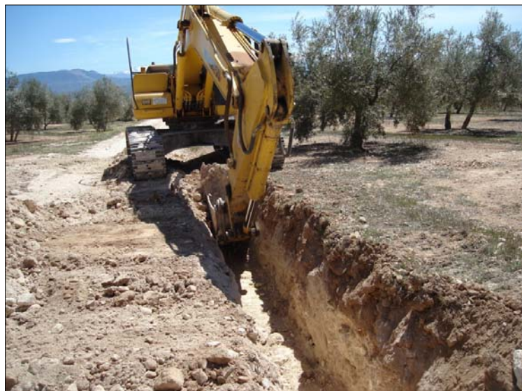
Lámina 9: Ejecución de la zanja en el tramo 6. Vista desde el S.
