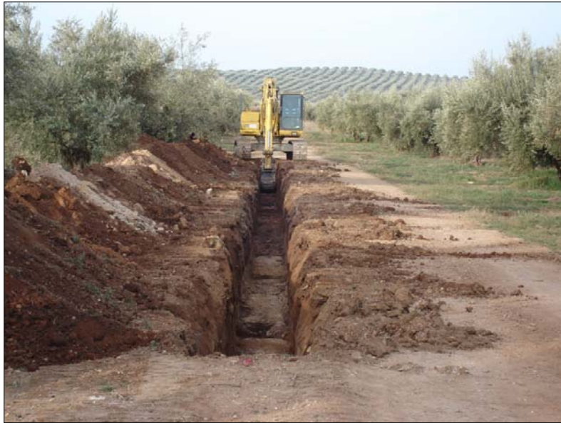
Lámina 10: Ejecución de la zanja en el Camino de los Llanos. Vista desde el N. Tramo 7.
