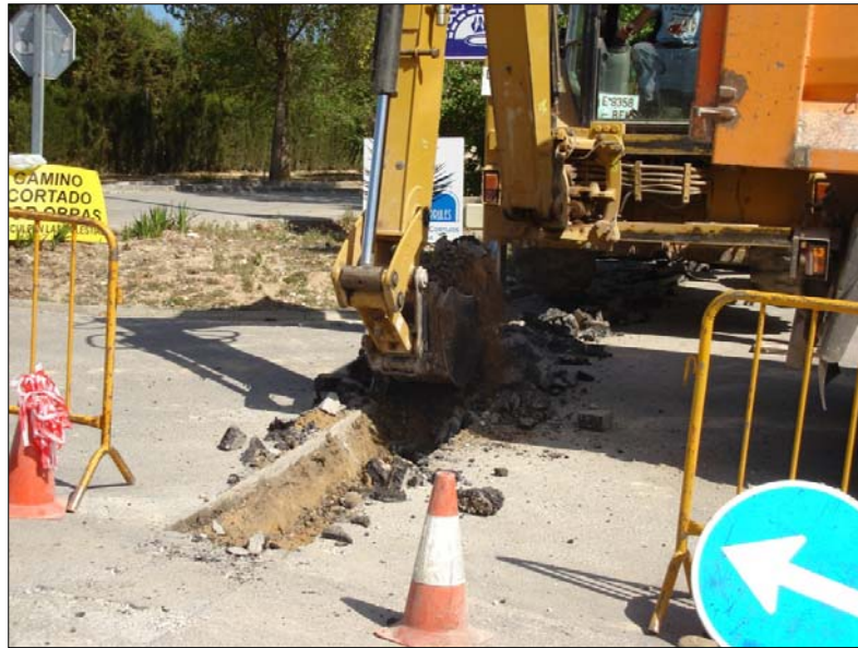
Lámina 8: Ejecución de la zanja en la entrada a la urbanización de Los Cortijos.
