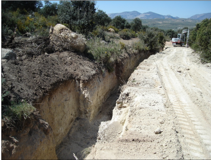
Lámina 5: excavación de la zanja en la loma de la Ermita. Tramo 3
