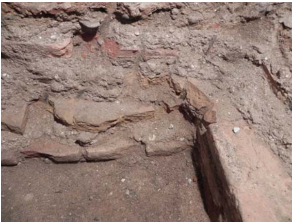
Detalle de la E.2. Se observa la presencia del alzado de muro sobre los ladrillos que sobresalen y constituyen la zarpa
