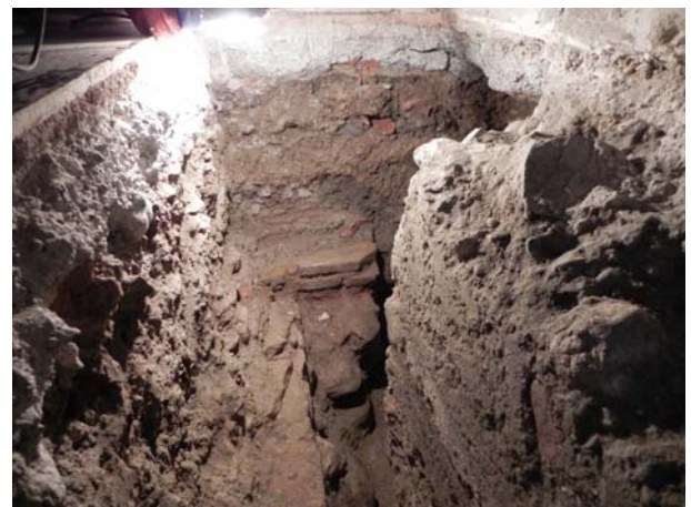
Detalle del encofrado y la base de piedras en la cara sur. A la derecha perspectiva de la cara Este.
