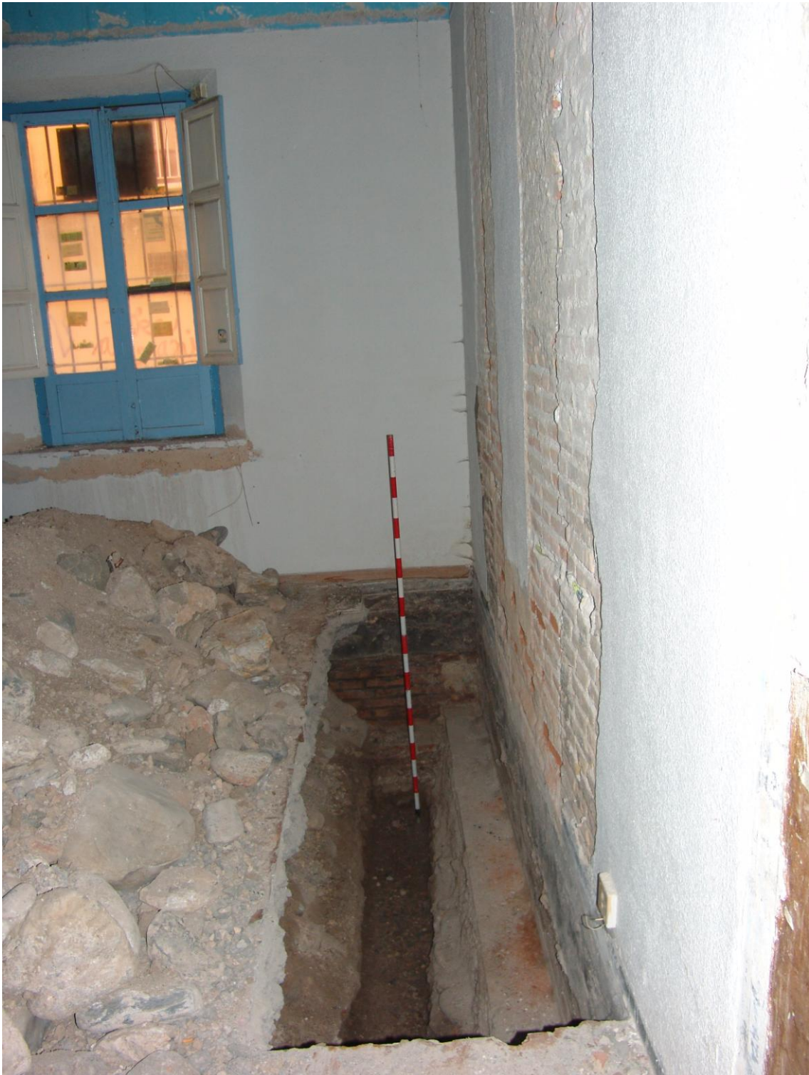
Imagen 3. Paramento 1 y zanja 1.
