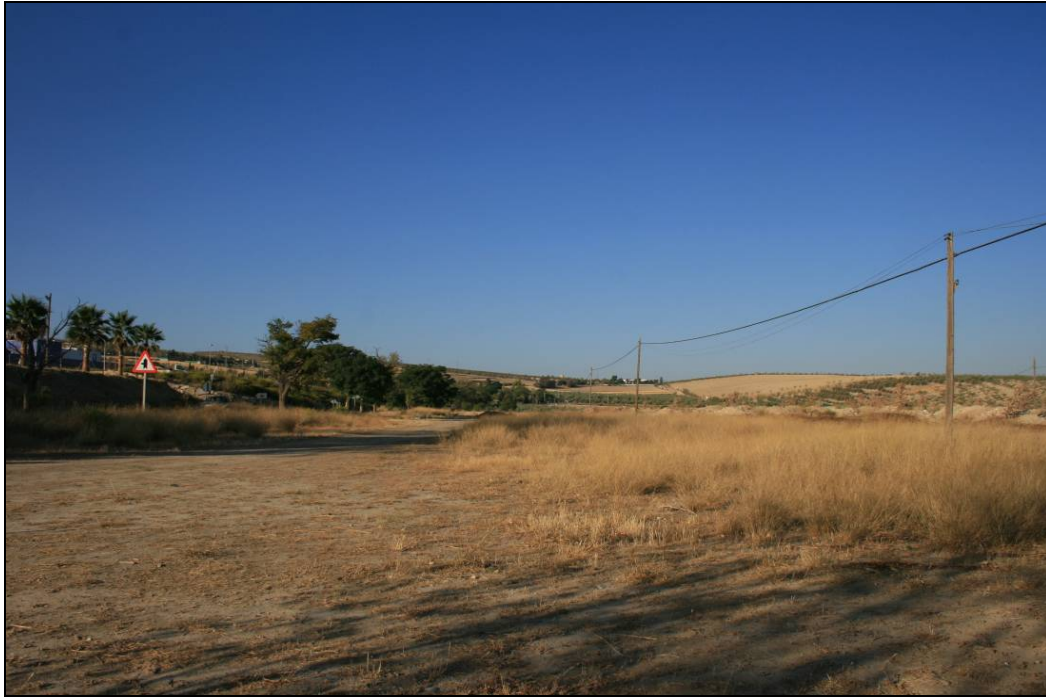
Foto 1. Vista desde el noreste del primer tramo del trazado (P.K. 0+100).
