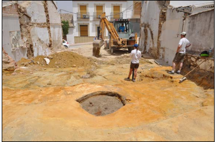
Lám.02. Trabajos de control de los movimientos de tierra. En primer plano se observa el pozo contemporáneo E-7.
