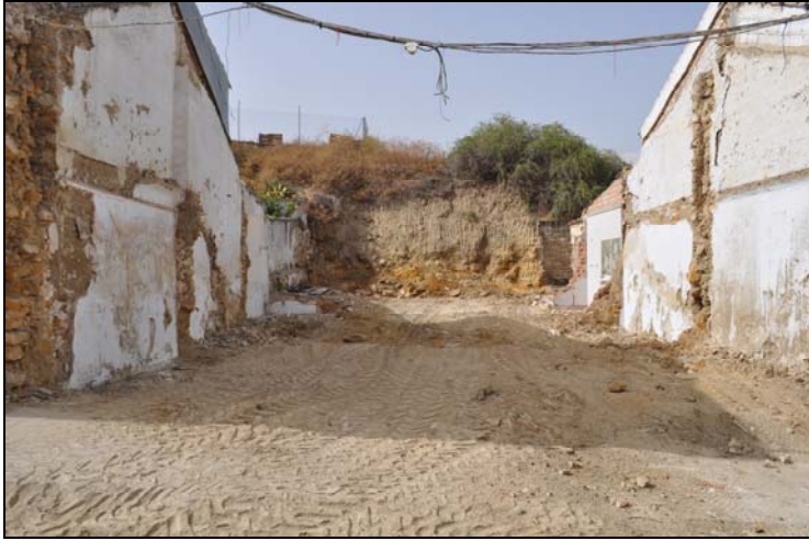
Lám.01. Solar tras la retirada de los escombros de la demolición.
