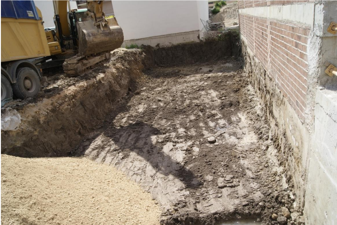
LÁM 3: Vista de la planta final.
