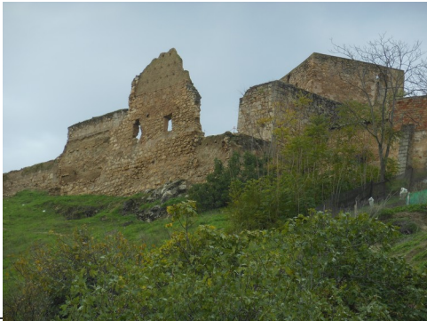
Lam 5. El castillo desde el este. Se trata del muro de la ampliación. El cierre de la derecha fue mucho más tardío.
