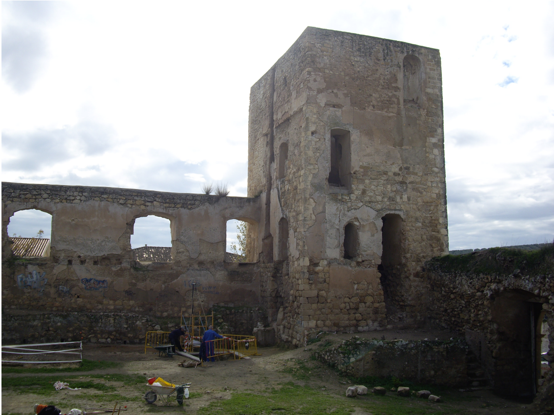
Lam. 1. La torre del homenaje. Al pie de la misma se coloca un cercado de protección para el silo.
