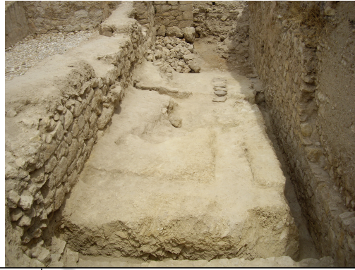
Lam 6. E espacio I, correspondiente a la zona ampliada, a la izquierda el muro primitivo, que enlazaba con la torre norte. A la izquierda el nuevo paramento.
