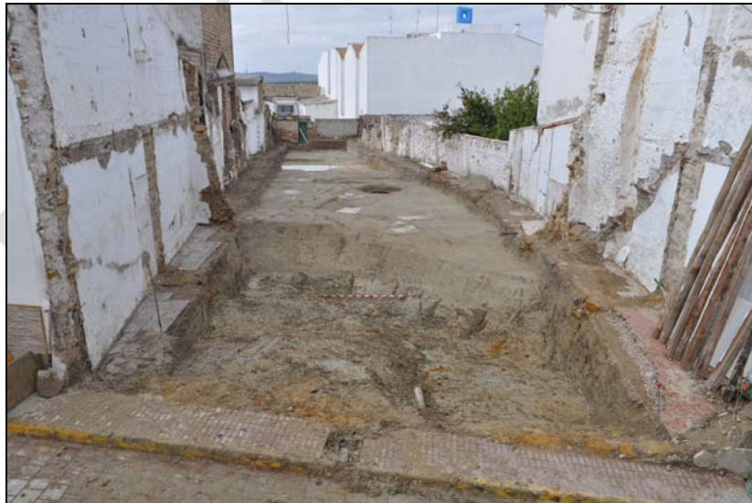
Lám.03. Vista general del solar donde se puede observar una vaguada en la zona delantera.
