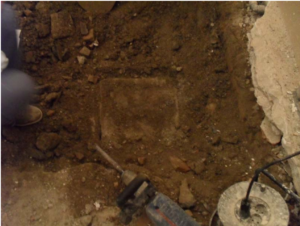
Lámina 3.-La Ue. 4 cubierta por la Ue. 3 e incluso protegida por alguna losa.
