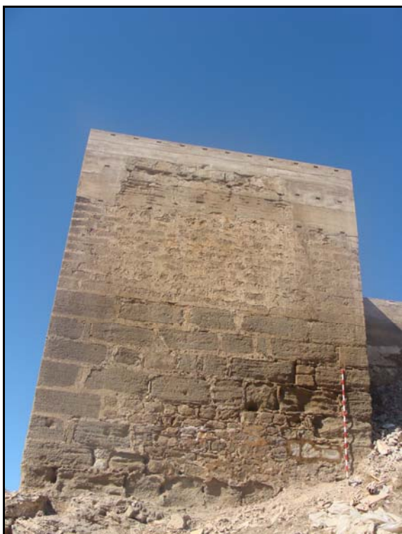
Lám. F. Estado final cara norte.
