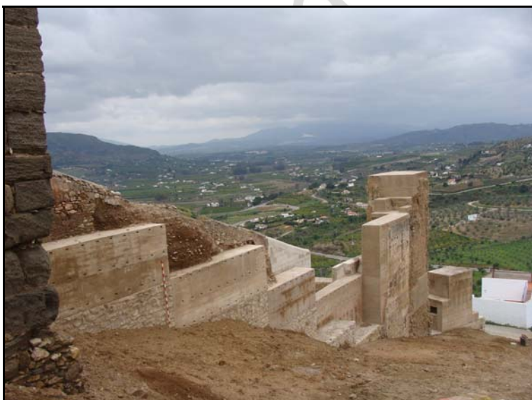
Lám. J. Vista final del tratamiento de consolidación de la muralla y la torre suroeste.
