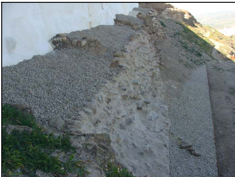
Lám. A. Estado final del Tramo 1.
