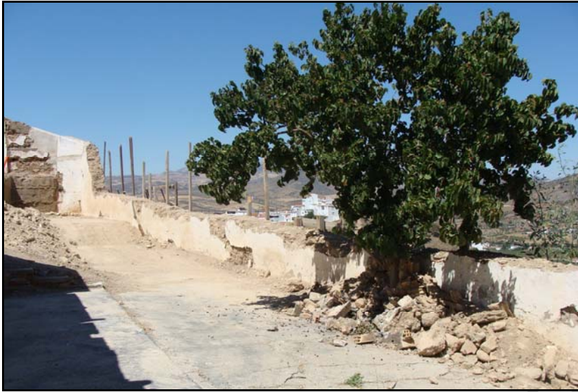
Lám. C. La tapia vista desde el interior, recortada para reducir su altura.
