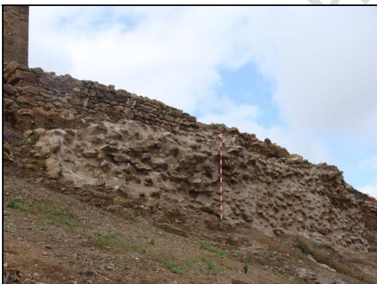
Lám. B. Vista general tras el proceso de consolidación del muro este, tramo 2.
