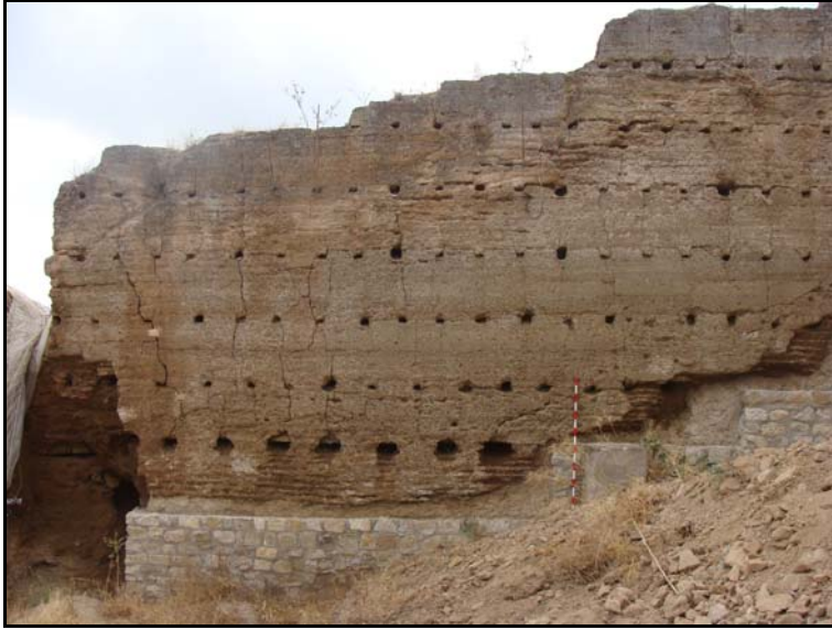
Lám. G. Estado previo cara oeste.
