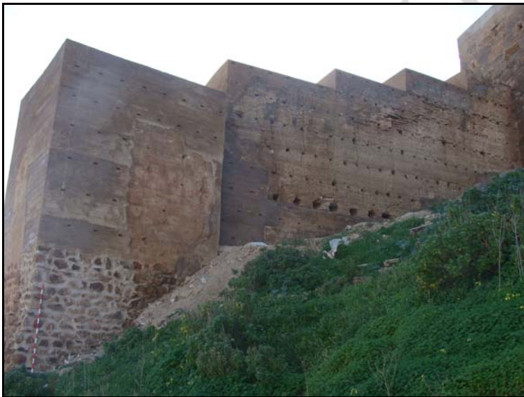
Lám. H. General acabado de la cara oeste de muralla y torre.
