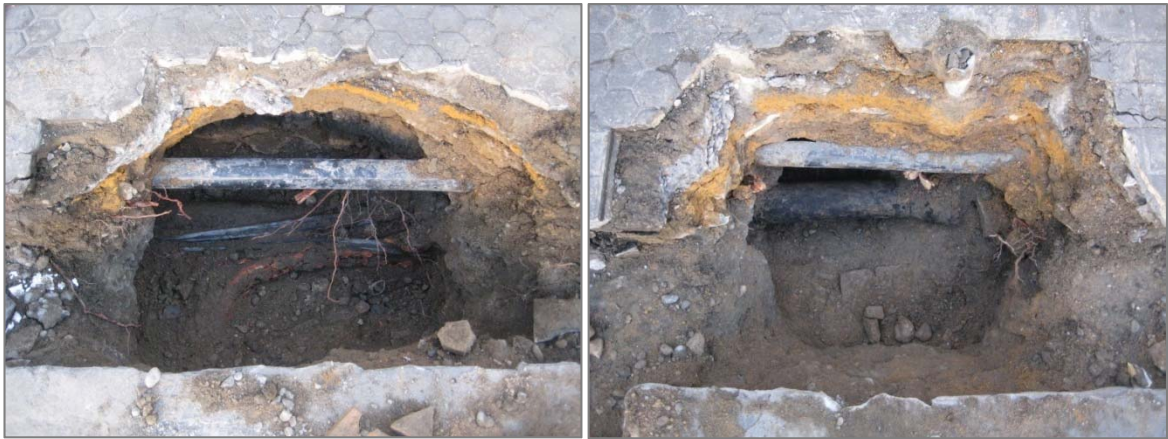
Lám. III. Vista general de las calicatas U.I. 3 a cota fin de rebaje
