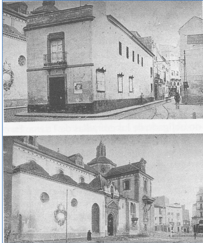
Láms. VIII y IX. Arriba, manzana derribada detrás de la cual puede verse parte de la fachada de la Epístola de la Parroquia de la Magdalena. Abajo, vista tomada desde la misma perspectiva después del derribo
