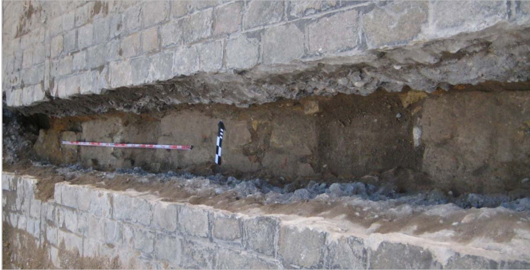
Lám. XI. Vista general de la alineación propuesta como antigua fachada de la manzana comprendida entre las calles Ciriaco Esteban y Mateo Alemán hacia la calle San Pablo, anterior al retranqueo que ha dado lugar a la fisonomía actual de la misma
