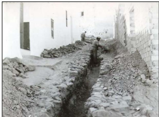
A medida que se iban retirando los restos de la tubería antigua y avanzando con la zanja, se iban colocando los tramos de tubo para la nueva canalización y cubriéndolos de arena.
