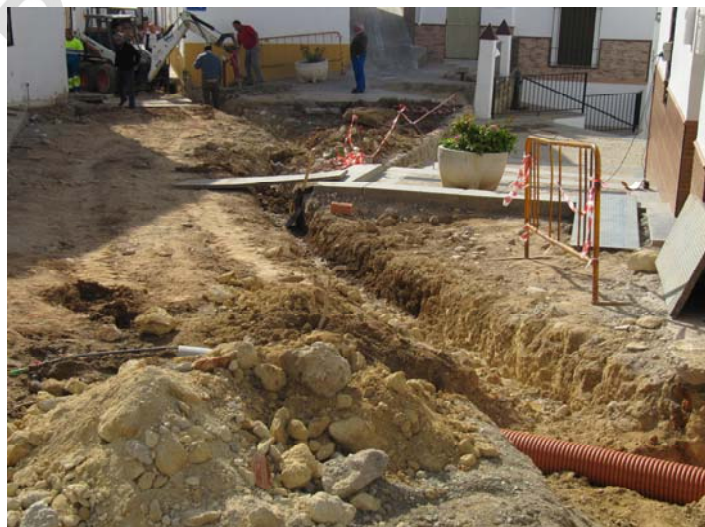
Ejecución de obras.
