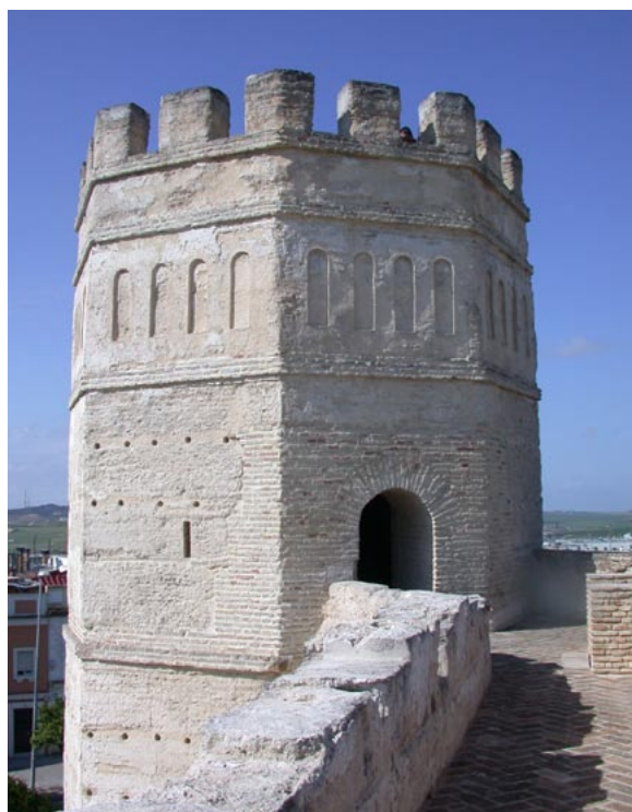
Fig. 53.- Torre octógona en el extremo sur. Detalle.
