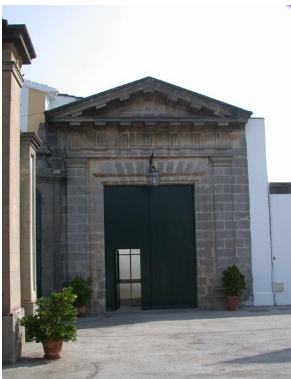
Fig. 63.- Detalle de posible acceso original de la puerta de Rota con fachada neoclásica.
