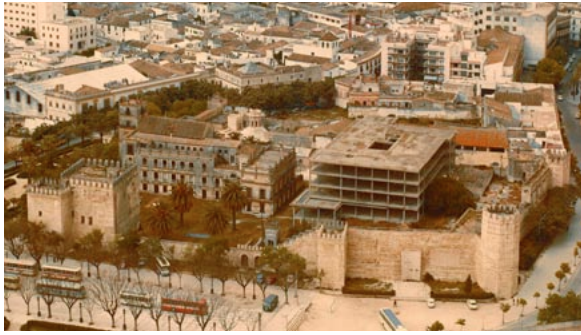
Fig. 70.- Vista aérea del Alcázar hacia 1974 con estructura del hotel en la parte central.
