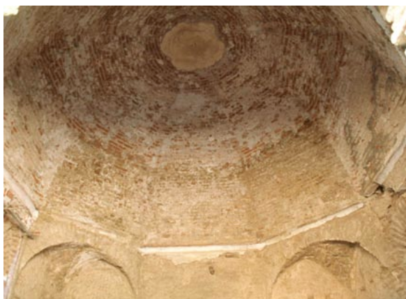
Fig. 77.- Edificio palatino. Cúpula de la habitación central.
