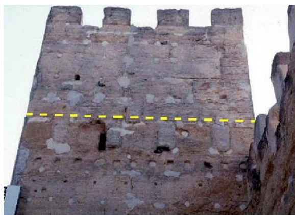
Fig. 119.- Detalle de torre en C/ Ancha en la que se aprecian las dos fases constructivas. La línea amarilla señala la altura de la primera línea de almenado.
