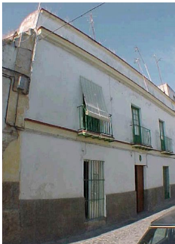
Fig. 14.- Casa TIPO D - patio de vecinos-. Fachada.
