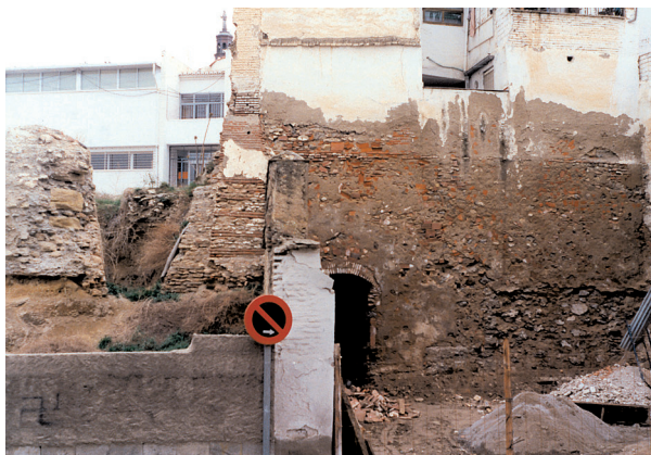
Figura 18: Adosamiento de la edificación a la muralla en la zona de San Miguel.
