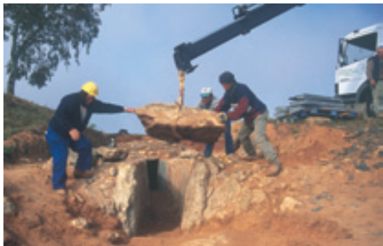
Figura 39: Detalle de la reconstrucción del corredor de la Tumba del Término.
