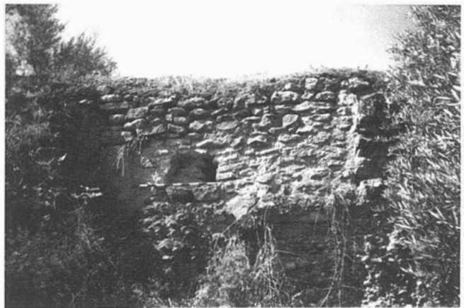
LAM. I: Villa de las Norias. Construcciones de época bajoimperial.
