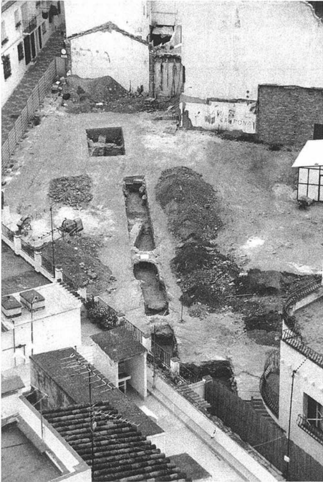
LAM. I. Vista general de la intervención.
