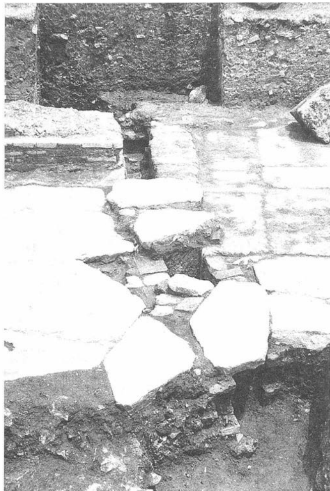
LAM. II. Vista desde el oeste del rebosadero; apréciase la distinta orientación y la amortización del contrafuerte ya destruido.
