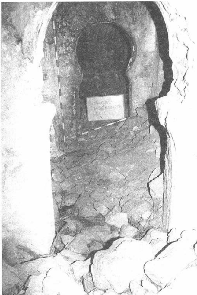
LÁM. I. Vista general al inicio de los trabajos.
