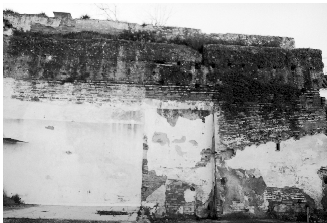
LÁM.1. La muralla almohade coronando el muro actual.
