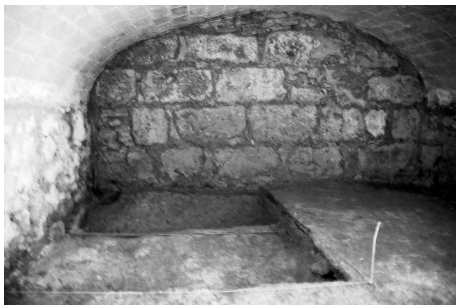
LÁM. II. Corte 3. Cimentación y alzado de la bóveda de descarga.
